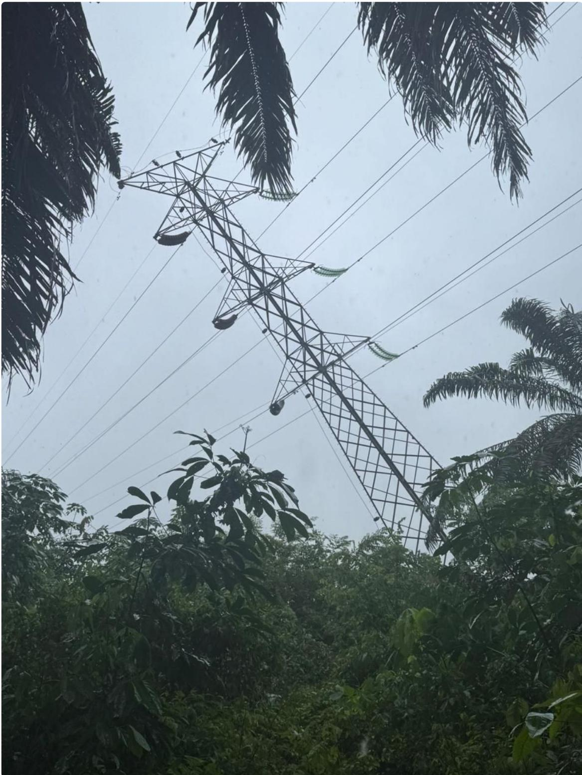
Adapun struktur yang mengalami kerusakan berada pada segmen Arun–Birun, yang mengalami patah pada traves line serta traves GSW sehingga pada jalur Birun–Peusangan turut terdampak dan membutuhkan penanganan cepat untuk mencegah dampak yang lebih luas pada distribusi listrik masyarakat.
